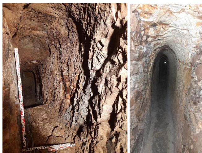
Figuras 3 e 4 –Minas antigas intersectadas pelo túnel
