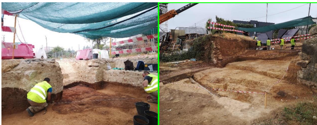
Figuras 1 e 2 – Trabalhos na Extensão da Linha Amarela, VSO, 3301 – Trabalhos de emergência na Quinta do Cisne.
