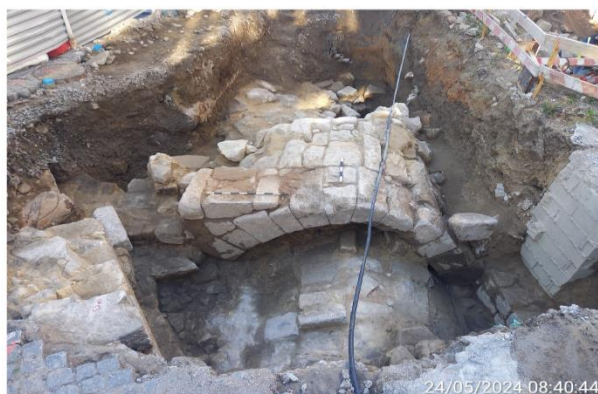
Figuras 5 e 11 – Desvio do Rio da Vila, Caixa Jusante: Ponte de S. Domingos e aqueduto do Rio da Vila
