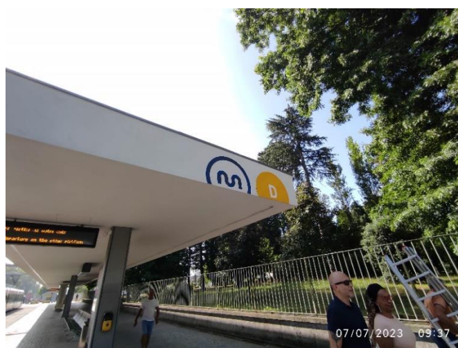
Foto 6 – Lado Norte pala da Estação Hospital de São João
