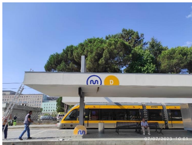
Foto 4 – Lateral pala da Estação Hospital de São João
