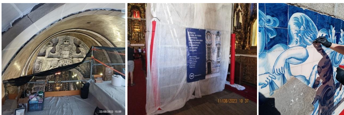
Figuras 17, 18 e 19 – Igreja do Carmo: aplicação medidas preventivas
