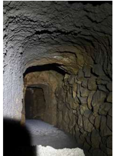
Estrutura hidráulica subterrânea (Túnel ST0)
